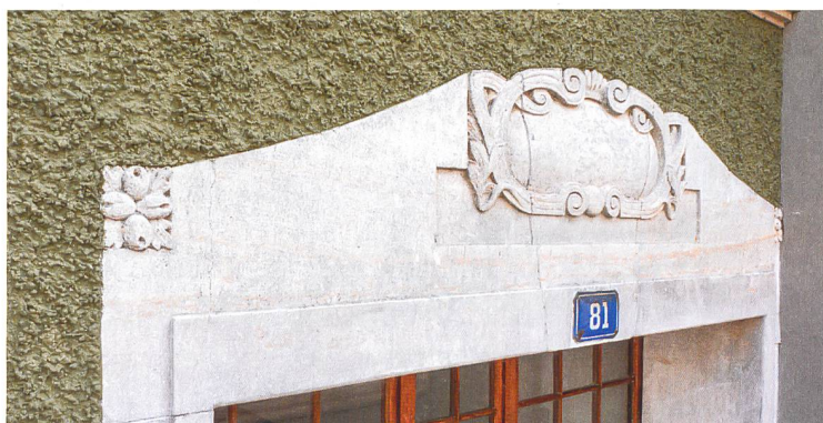
Die Sandsteingewände blieben erhalten. Sie konnten um zwei Zentimeter aufgedoppelt werden.
