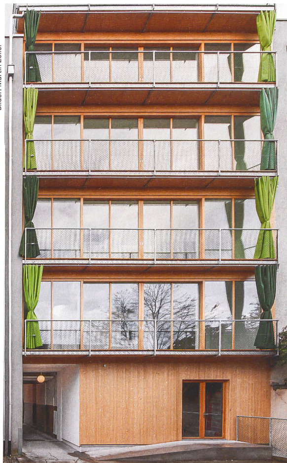
Auf der Hofseite erstellte man eine neue Raumschicht mit einer vollverglasten Holzbaufassade.
