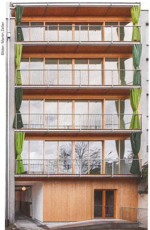
Auf der Hofseite erstellte man eine neue Raumschicht mit einer vollverglasten Holzbaufassade.
