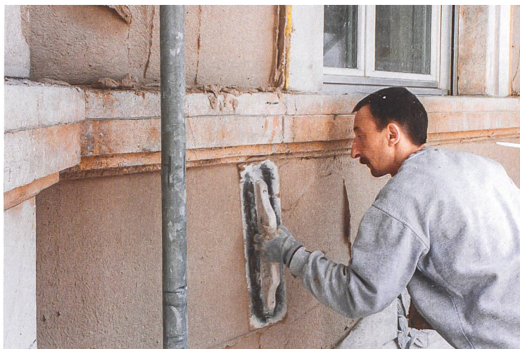
Aufbringen des Aerogel-Putzes.
