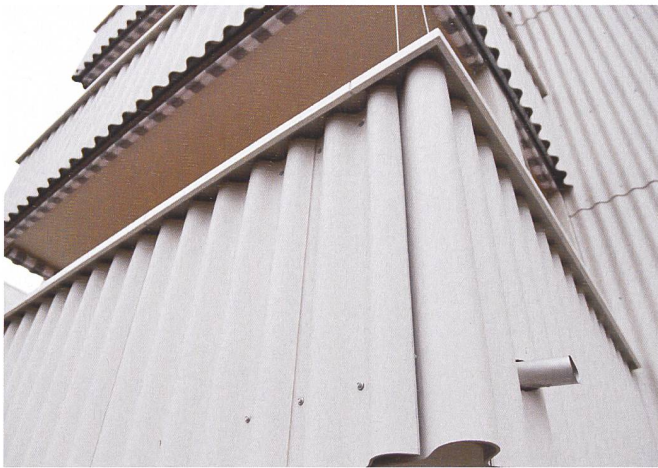
Nahaufnahme der Eternitverkleidung.
