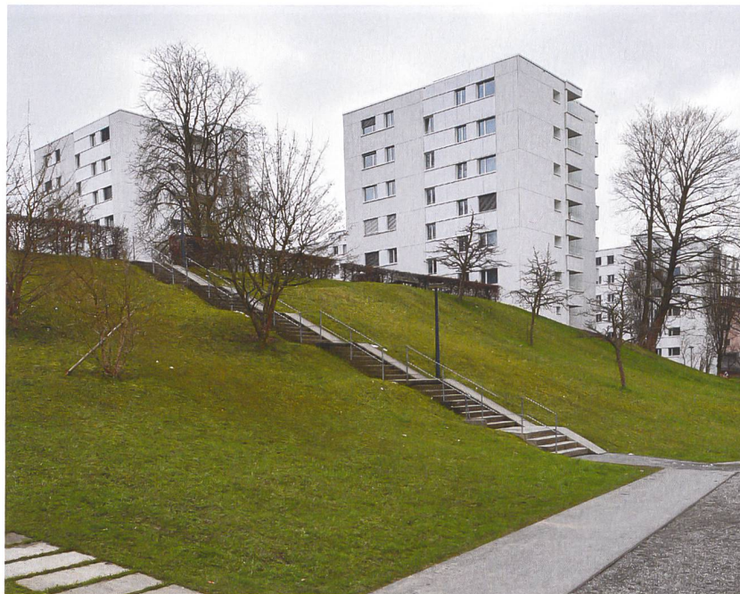
Unter der hinterlüfteten Fassade befinden sich 15 Zentimeter Dämmung. Die Fenster sind neu dreifachverglast.
