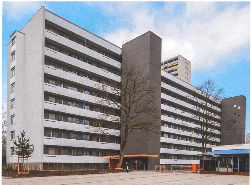
Die Ostseite blieb im Originalzustand erhalten. Hier baute man bloss die beiden Treppentürme von Grund auf neu.
