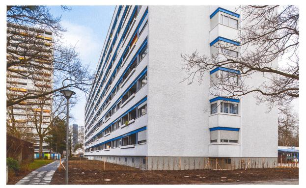
An der Westfassade wurde über die gesamte Gebäudelänge eine neue, drei Meter tiefe Schicht angebaut. Mit ihren Fertigbauteilen orientiert sie sich am ursprünglichen Erscheinungsbild.
