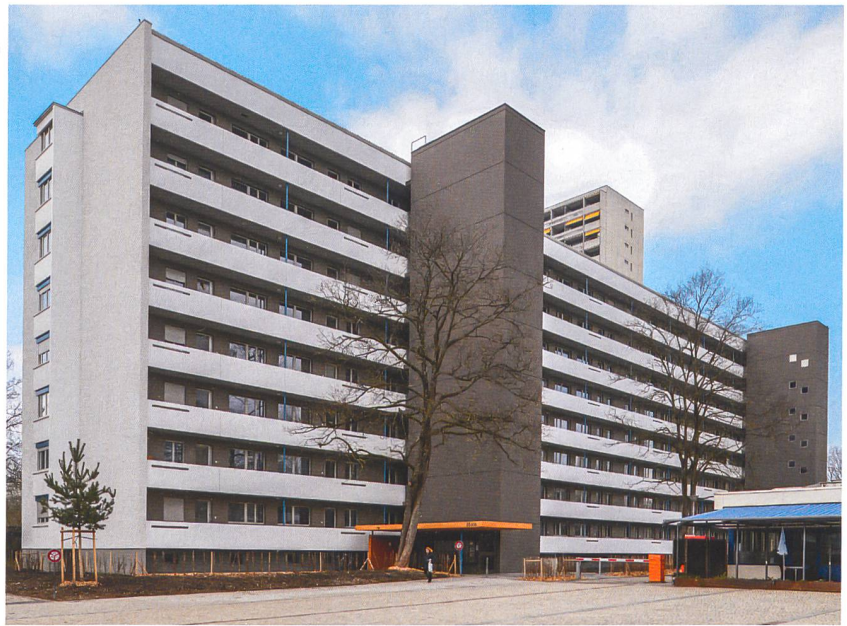
Die Ostseite blieb im Originalzustand erhalten. Hier baute man bloss die beiden Treppen- und Lifttürme von Grund auf neu.
