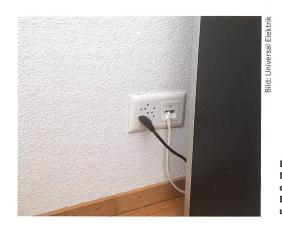
Einmal verlegt, sind vom POF-Netz nur noch die Anschlussdosen sichtbar. Sie können bei Bedarf ausgetauscht werden, um die Kapazität zu erhöhen.
