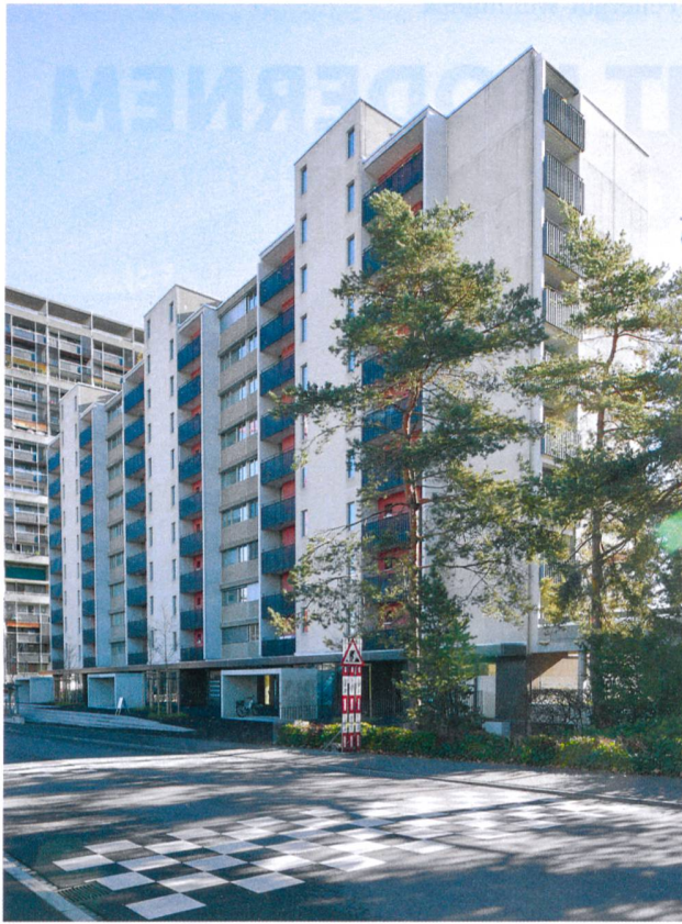
Auch die nordseitige Strassenfassade erfuhr kaum Veränderungen. Nur im Bereich der Küchenbalkone brachte man eine zusätzliche Aussendämmung an. Zudem ersetzte man die Balkonbrüstungen durch transparente Blechelemente. Neu gestaltet ist der Vorplatz.
