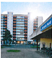
Titelbild: Der Eingangsbereich des frisch renovierten Wohnblocks Fellergut der EBG Bern richtet sich neu gegen den Bahnhof aus. Bild: Martin Bichsel
