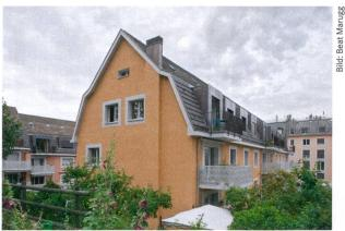
Die Baugenossenschaft Wiedikon nahm bei ihrer Kolonie II an der Steinstrasse eine Aussensanierung vor und baute grössere Balkone an. Zudem ersetzte sie Teile des Mansardengeschosses durch eine Holzkonstruktion, erneuerte die Lukarnen und versah Dachwohnungen mit neuen Balkonen.
