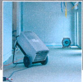
Bautrocknung
