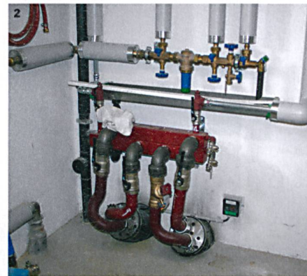
1 Zuleitung der Fernwärme vom Hauptstrang in der Übergabestation im alten Geschäftshaus.
