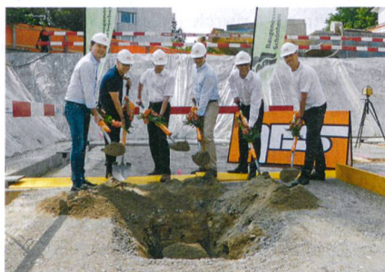
Am 11. Juni setzten Baugenossenschaft, Architekt und GU zum Spatenstich für den Neubauteil der Siedlung Eyhof an.
