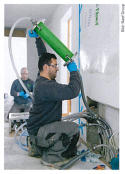
Im Rahmen einer Komplettsanierung mit dem HAT-System werden die Heizkreise mit einer Epoxidharzlösung von innen neu beschichtet.
