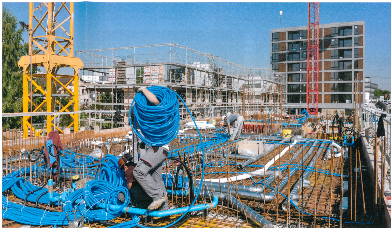
Einbau der Zu- und Abluftleitungsrohre in der Siedlung Living 11 der ASIG. Das weit verzweigte Leitungsnetz ist an den zentralen Monoblock angeschlossen.
