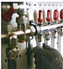
Titelbild: Finish nach der Reinigung oder Sanierung einer Fuss- bodenheizung: Montage von neuen Verteilern. Bild: Naef Group
