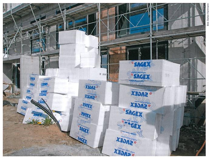
Ab dem 21. August 2015 sind EPS-Dämmplatten mit dem Flammschutzmittel HBCD verboten. Die Industrie hat darauf bereits reagiert. Trotzdem wird uns die Entsorgung des belasteten Altmaterials noch lange beschäftigen.
