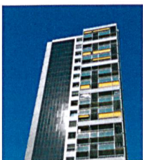
Titelbild: Im Rahmen einer Gesamt- sanierung ihres Hoch- hauses Kasparstrasse erstellte die FAMBau eine Fotovoltaikanlage an der Fassade. Bild: zVg.
