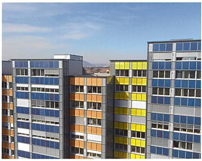
mit integraler GAP-Fassaden-Technologie. Die beiden Mehrfamilienhäuser sollten in moderne Gebäude mit einer weiteren Lebensdauer von fünfzig Jahren verwandelt werden. Die Sanierung erfolgte in bewohntem Zustand. Dabei wurden die alten Balkone in die Gebäudehülle integriert und vergrössern heute als Loggien mit Schiebefenstern die Wohnungsfläche um 26 Prozent. Die Montage der GAP-Fassade auf der Baustelle nahm knapp sechs Monate in Anspruch.
