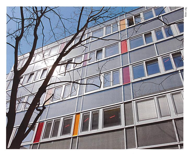
Auf dem Weg zum  $\mathrm{CO}_2$ -neutralen Gebäude ist die Firma Swissrenova einen Schritt weiter. Sie stützt sich bei ihren Gebäudesanierungen auf die in Österreich entwickelte GAP-Fassadentechnologie. In diesen Häusern gibt es keine Heizung mehr; Wärme wird in der Fassade erzeugt.
