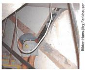
Ältere Häuser sind auf vertikale Belastungen ausgerichtet, doch Erdbeben schwingen horizontal. Nachträgliche Aussteifungen sorgen für Stabilität – hier in Form einer durchgehend verschweissten Diagonalarmierung.
