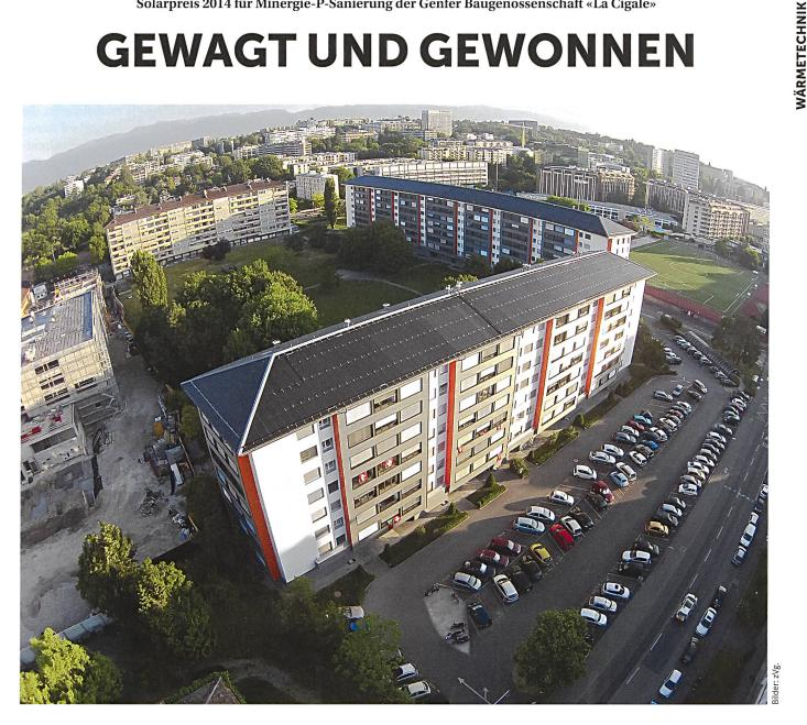
Die beiden Scheibenhäuser der Baugenossenschaft «La Cigale»: Auf den Dächern sind die unverglasten Sonnenkollektoren ersichtlich, das Herzstück der neuen Wärmetechnik.
