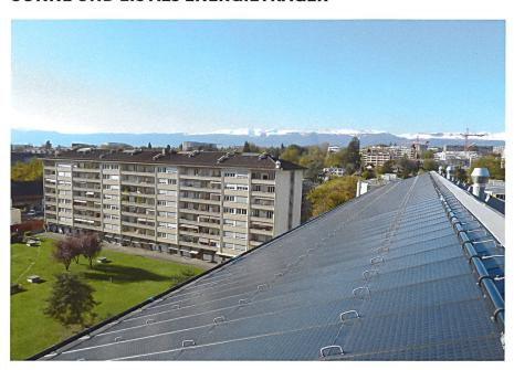
Die Sonne produziert 82 Prozent der Heizenergie und des Brauchwassers. Spezielle Sonnenkollektoren und Wärmepumpen, die mit Eisspeichern kombiniert sind, machen es möglich.
