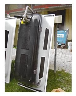
Wannen werden zur Schallverminderung vom Baukörper getrennt und seitlich mit Dämmstreifen oder Gummibändern versehen.
