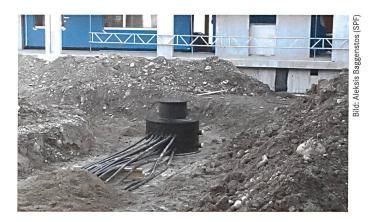
Schacht des Erdsondenverteilers in der Siedlung Oberfeld in Ostermundigen. Ob der Regenerationseffekt beim Erdspeicher funktioniert, untersucht ein Hochschulprojekt.
