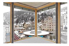
Holzfenster sind stilvoll und verbreiten eine angenehme Stimmung. Im Unterhalt sind sie jedoch aufwendiger, da sie auf der Fassadenseite schnell verwittern. Hier bietet das neue Holz-Aluminium-Fenster WS1 von Ego Kiefer eine Lösung: aussen Aluminium, innen Holz. Dieses spezielle Renovationsfenster komplettiert das Fenstersortiment des Altstätter Unternehmens im Bereich Renovation.
