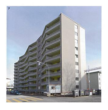
heranwachsende Balkonschicht beziehungsweise deren Brüstungen. Dies bedeutete, dass der Platz für die 18-Zentimeter-Steinwolldämmung zunächst ausgespart werden musste. Diese Schicht, eine verputzte Kompaktfassade, baute man erst nach Erstellung der Balkone ein.
