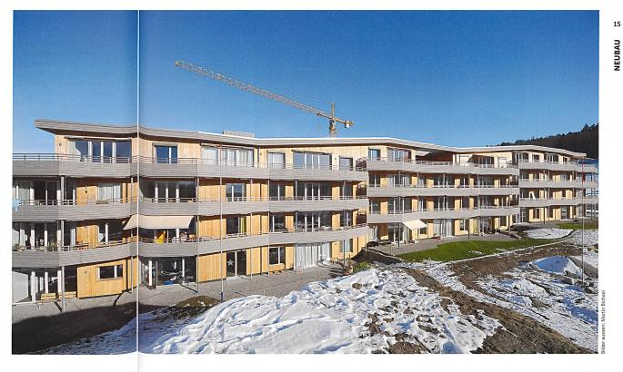
Prägnanter Holzbau: Verschiedene Hölzer, geknickte Fassaden und durchgehende «Zickzackbalkone» sorgen beim Block C im Oberfeld für Dynamik.
