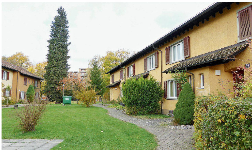
Die Mattenhof-Siedlung wird ab Januar in zwei Etappen abgebrochen.
