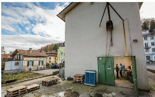
Die ehemalige Werkstatt des Gallati-Hauses kann gut als Ausstellungsraum genutzt werden – für Adriana Zürcher und Lukas Geissler einer der Vorzüge des Künstlerhauses.
