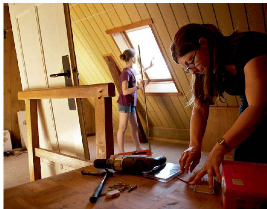
Die Mädchen haben sich einen «Girl's room» unter dem Dach gebaut.
