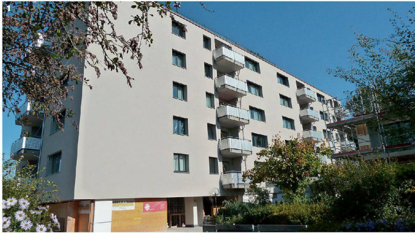
1/2 Haus 19 mit neuer hinterlüfteter Fassade und vergrösserten Balkonen.
