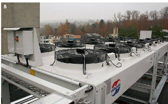
4/5 Auf dem Dach von Haus 19 ist schon ein Teil des neuen Energiekonzepts ersichtlich: Sonnenkollektoren (oben) und Rückkühler (links), der die Wärmepumpe speist.
