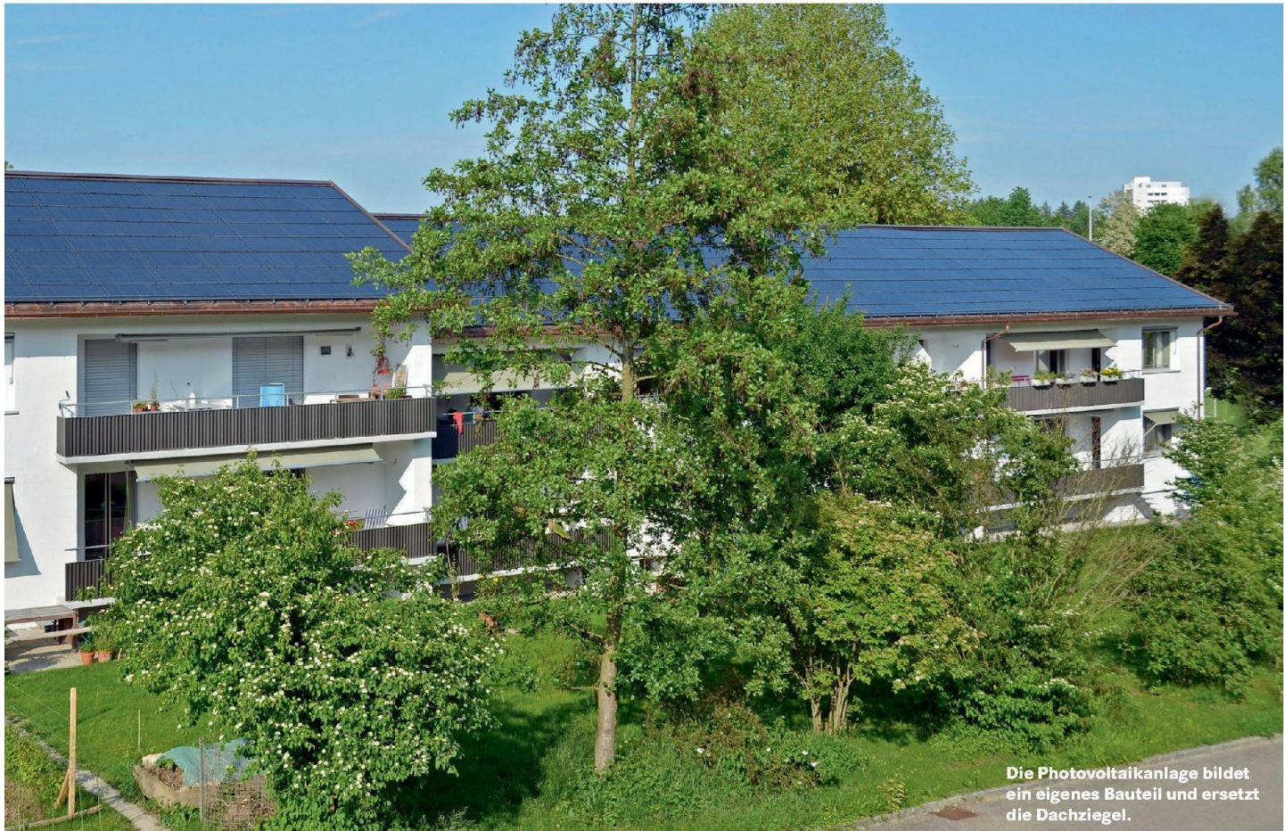
Die Photovoltaikanlage bildet ein eigenes Bauteil und ersetzt die Dachziegel.
