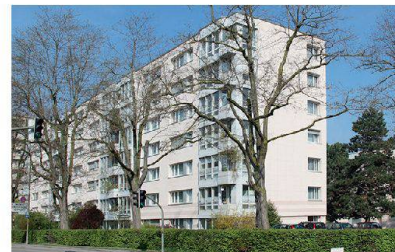
Die Baugenossenschaft zum Stab denkt an die Seniorinnen und Senioren und saniert altersgerecht.
