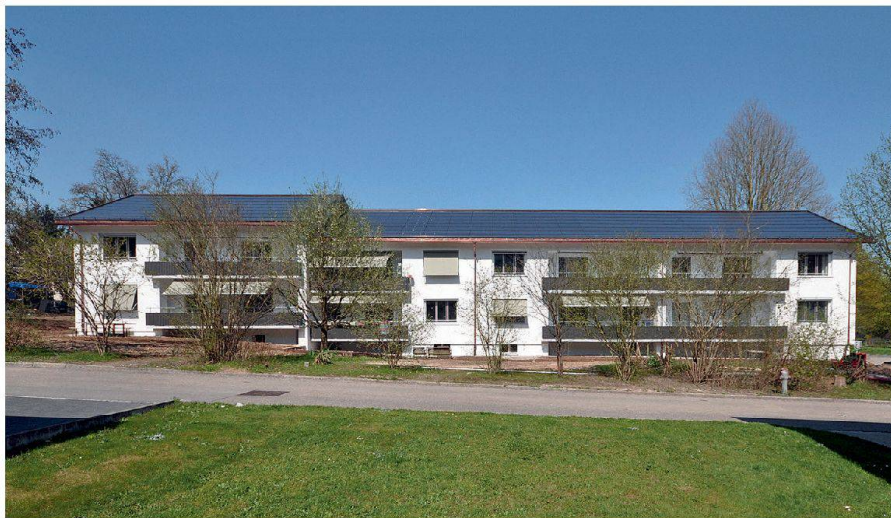
Gesamtenergiebedarf um achtzig Prozent gesenkt: Liegenschaft Hans-Hässig-Strasse in Aarau.
