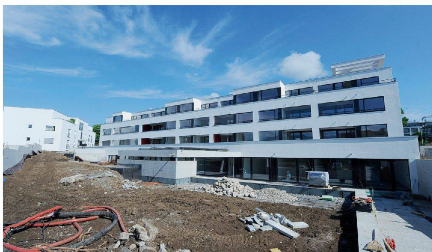
Im Durchschnitt kosten Genossenschaftswohnungen zwanzig Prozent weniger als das übrige Angebot. Im Bild die 2011 fertiggestellte Siedlung Geren in Stäfa (ZH) der Gewo Züri Ost.
