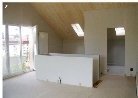
1–3 Der neue Dachaufbau besteht aus vorgefertigten Holzelementen.
