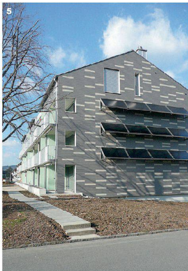
1–4 15 Zentimeter Dämmung verstecken sich hinter der eleganten neuen Eternitverkleidung (Bild 2: früherer Zustand).
