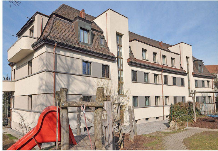
Horizontale Gliederung: Renovierte Eingangsseite.
