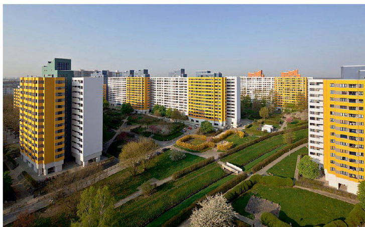
Die Riesenbauten lassen grosszügige Grünräume frei. Mit neuen Farbakzenten betont die Gesobau die ursprünglichen architektonischen Gestaltungselemente.
