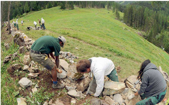
Lehrlinge aus fünf Genossenschaften stellten in Bergün eine Natursteinmauer instand.
