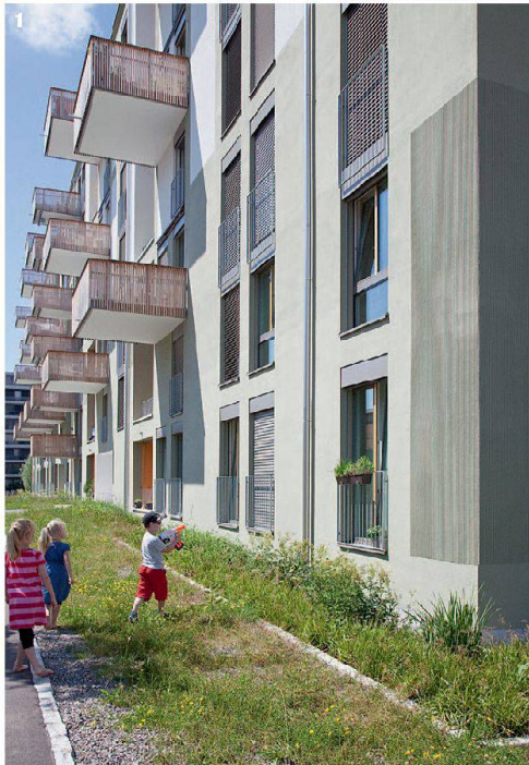
1 Eine Art Burgraben, wo das Dachwasser versickern kann, zieht sich ausser um die Häuser.
