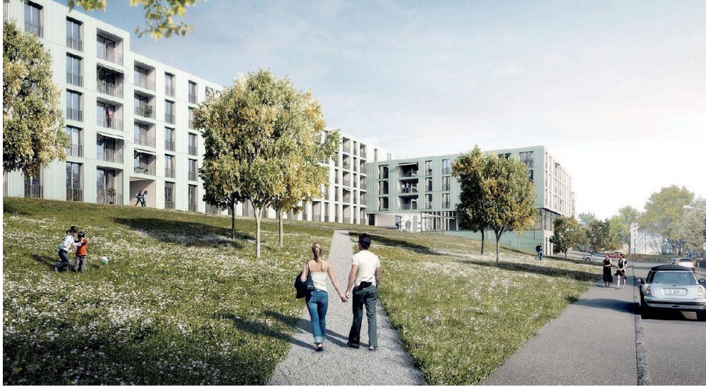
Die FGZ strebt das Minergie-Label nicht um jeden Preis an, setzt beim ökologischen Leuchtturmprojekt Zentrum Friesenberg aber ganz bewusst auf Minergie-P-Eco.
