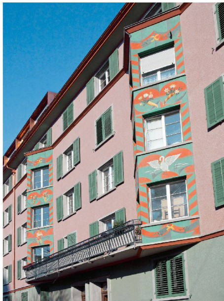
Eine heile Welt zeigen die denkmalgeschützten Fassadenmalereien, die sorgfältig erneuert wurden.
