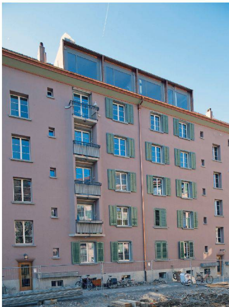
Blick in den Innenhof nach abgeschlossener erster Etappe. Hier wurden Fenster ersetzt und Fassaden erneuert, während es in der zweiten Etappe auch Balkonanbauten geben wird.
