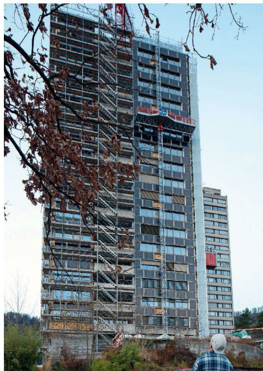
«Fassadenbänder» bestimmen das neue Erscheinungsbild.
