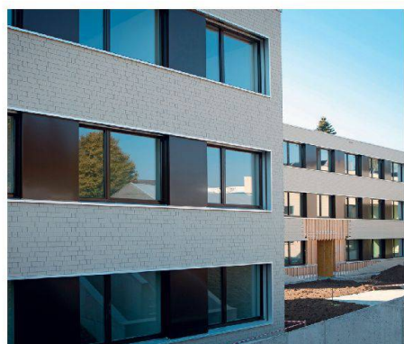
Blick auf die Eingangsseite.
