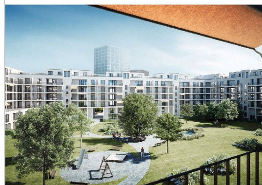
Das Richti-Quartier in Wallisellen ist die erste Arealüberbauung der Schweiz, die den Kriterien der 2000-Watt-Gesellschaft entspricht. Allreal erstellt hier Wohnraum für 1200 Menschen und 3000 Arbeitsplätze.
