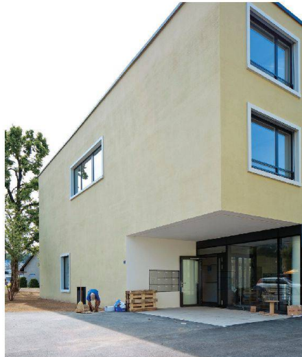
Eingang zum «Gemeinschaftshaus», das unter anderem Café, Pflegebad, Fitnessraum und Spitex beherbergt.
