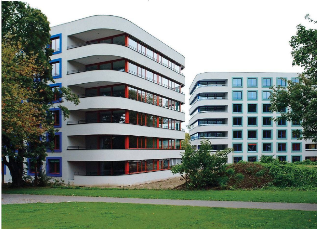
Jeder Bau hat sein eigenes Farbkonzept. Der grosszügige Grünraum blieb weitgehend erhalten.
