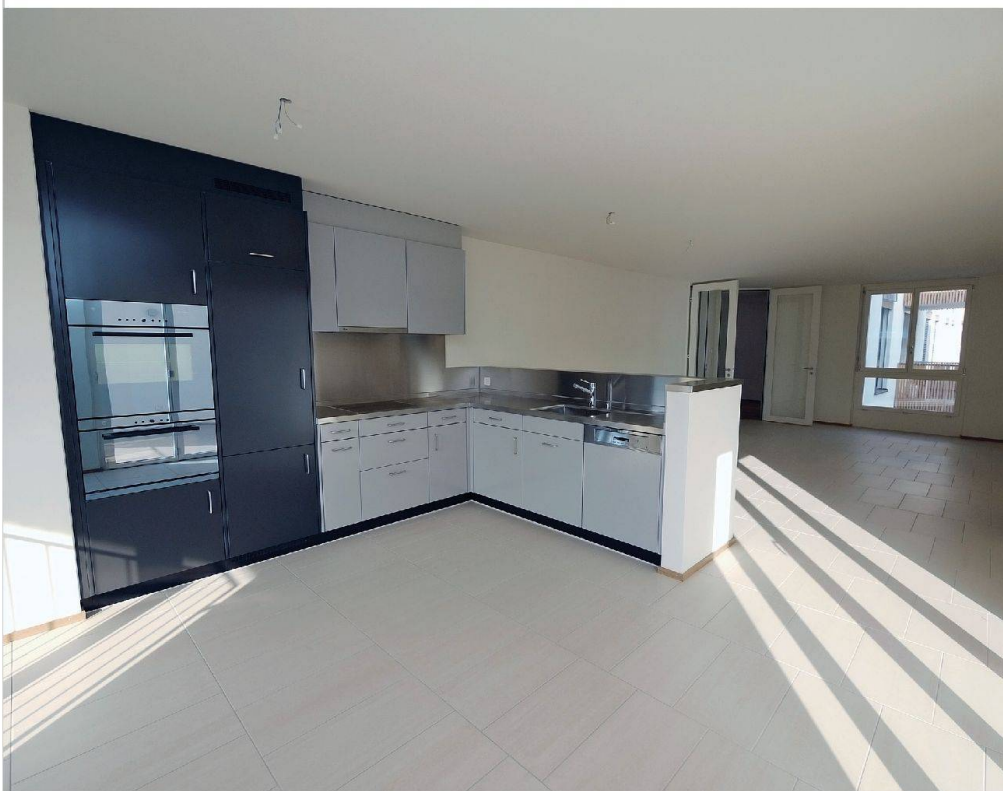
Die BGH entschied sich für Stahl-Winkelküchen und Keramikböden. Die Decken liess sie verputzen.
