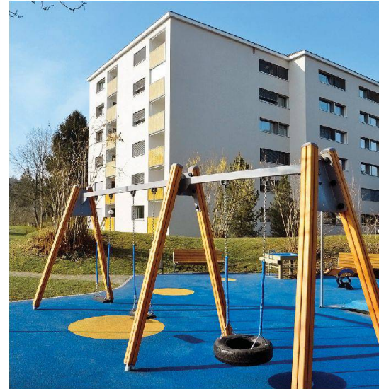
Die Gebäudehüllen wurden gedämmt, die Fenster erneuert.
