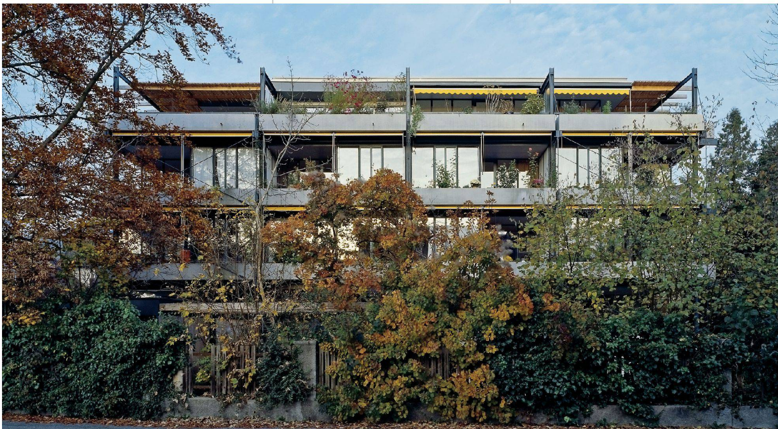
Die horizontalen Stahlträger bestimmen das Erscheinungsbild der Geissburg.
