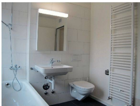
Auch die Bäder wurden rundum erneuert.
