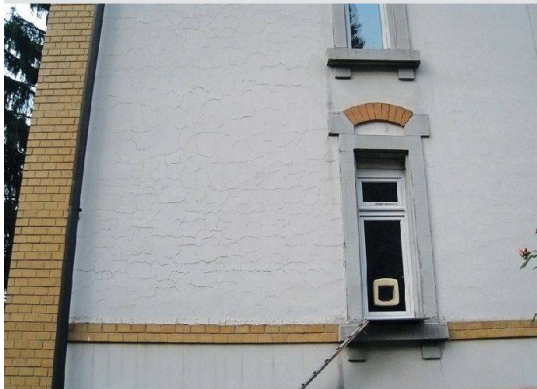
Ganz oben: Haus vom gleichen Bautyp wie die Gebäude auf dem Bild rechts: Im Zuge der Fassadenrenovierung hat es jeglichen Schmuck verloren. Darunter: Fassadenschäden nach unsachgemässer Renovation.
