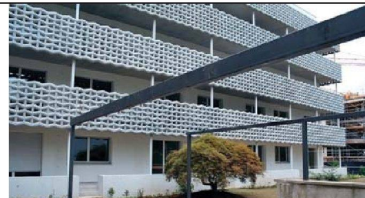
Die ornamentalen Balkonbrüstungen prägen das Erscheinungsbild der Siedlung Feldblume.
