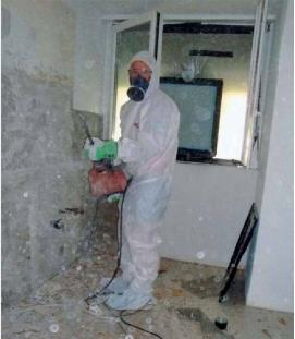
Asbestsanierung bei der Genossenschaft Hofgarten: Damit kein Asbest in die anderen Wohnungsräume gelangte, wurde mit Lüftungen ein Unterdruck erzeugt. Bei der Entsorgung tragen die Arbeiter komplette Schutzkleidung.
